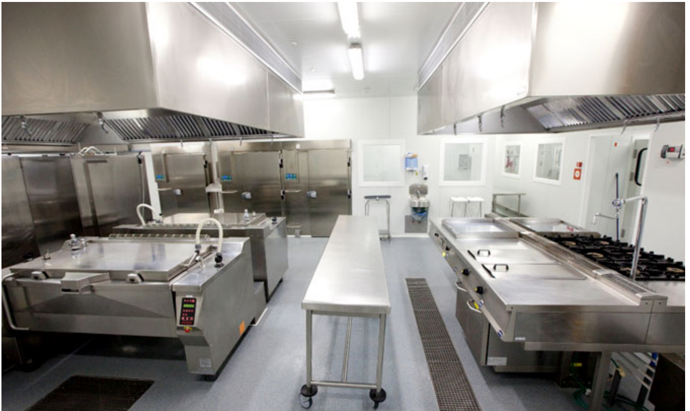
El suelo y los desagües son dos de las cinco zonas más comunes donde se puede encontrar la Listeria .
